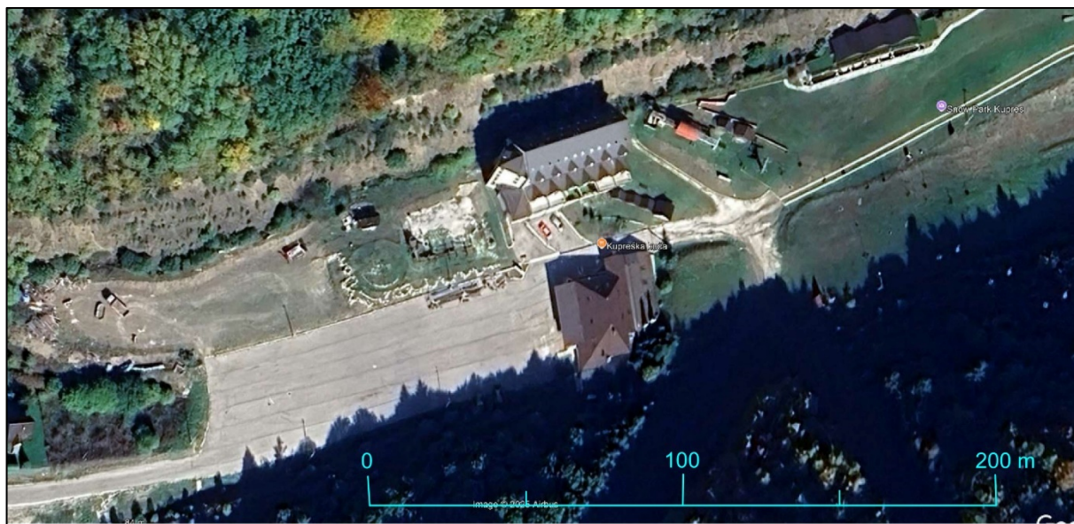
Slika 24. Hotelski kompleks „Kupreška kuća“
